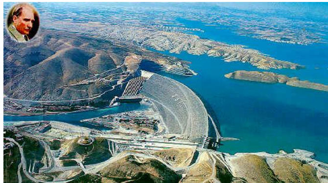
Το μεγάλο φράγμα «Ατατούρκ» της Τουρκίας στον ποταμό Τίγρη
